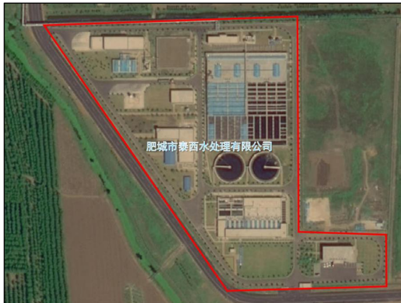
图 3.1-20 泰西污水处理厂卫星图
